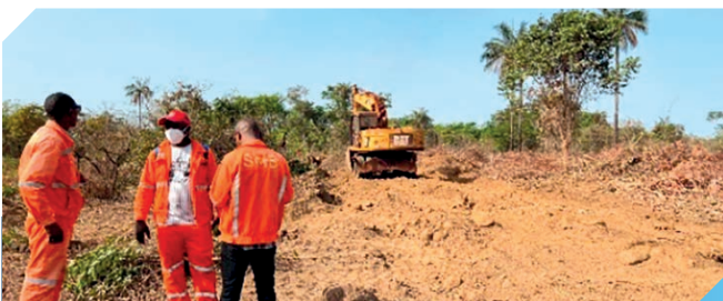
當地社區 道路維修
